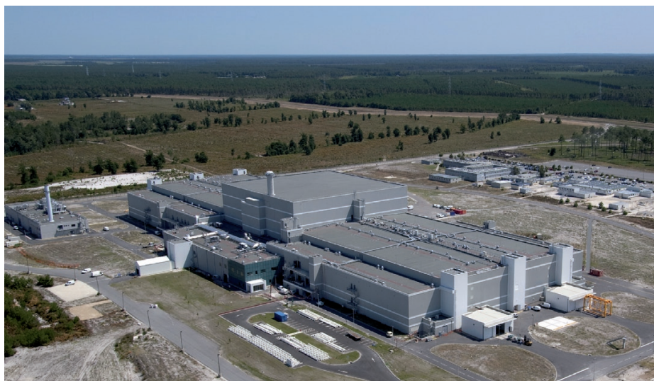
3. Photographie aérienne du Laser Mégajoule en construction au CEA-CESTA. © CEA G2I Vertigo
